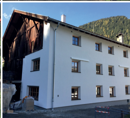
Die Fassadenelemente werden inklusive Dämmung, Haustechnik und Fenster im Werk vorgefertigt und können ohne Gerüst montiert werden.
