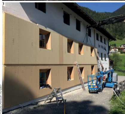
Die Fassadenelemente werden inklusive Dämmung, Haustechnik und Fenster im Werk vorgefertigt und können ohne Gerüst montiert werden.
