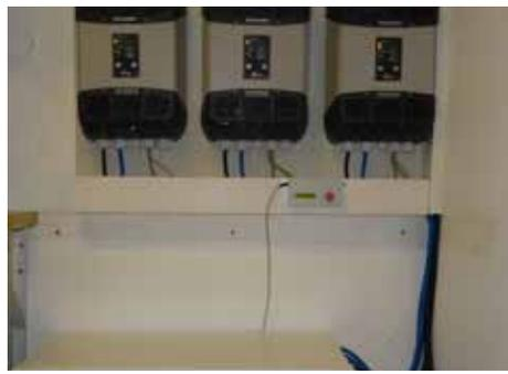
19,5 kWh Speicher mit Wechselrichter,
